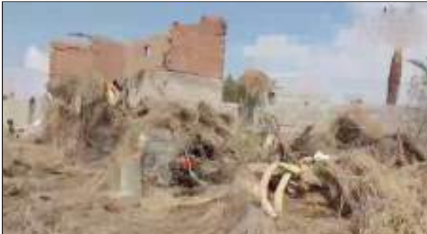
صورة موثقة تظهر جانب من الدمار الذي لحق بمنزل المواطن (إبراهيم علي أحمد شراعي)
