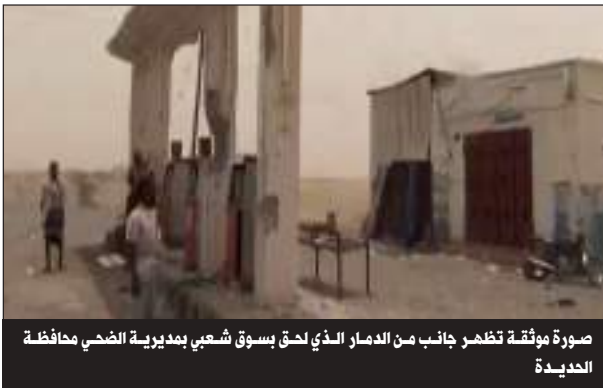
صورة موثقة تظهر جانب من الدمار الذي لحق بسوق شعبي بمديرية الضحي محافظة الحديدة
