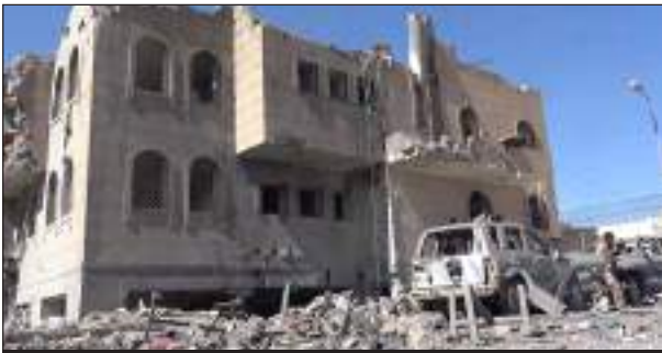
صورة موثقة تظهر جانب من الدمار الذي تعرض له المبنى المستهدف
